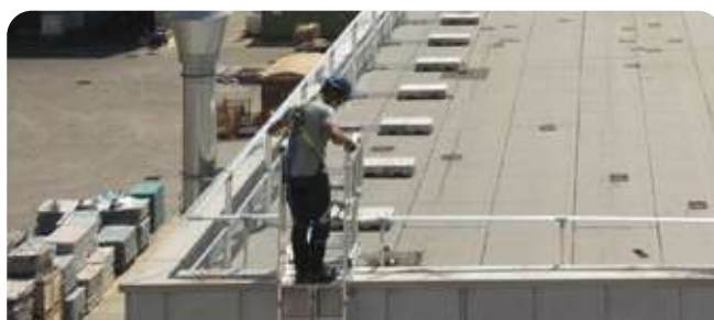
Accesso in copertura
