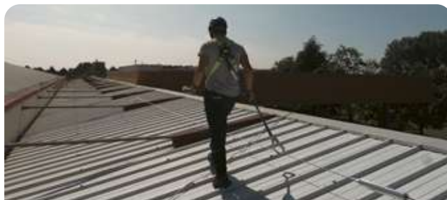
Camminamento in copertura
