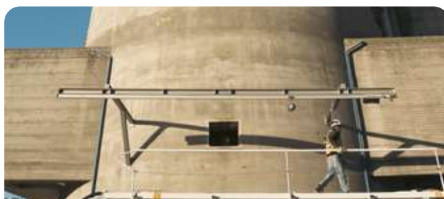
Baie di carico
